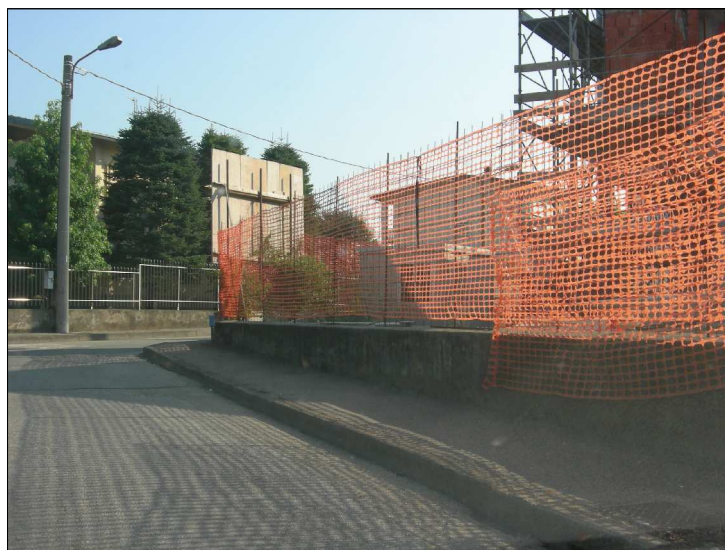
Posizione: Via Gramsci - Via Pellico Tipologia: Impianti Istituzionali
