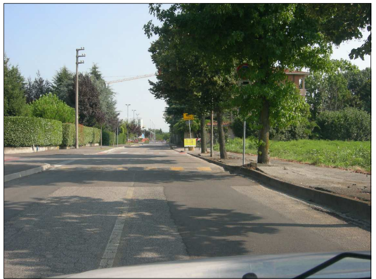
Posizione: Via Don Minzoni Tipologia: Impianti Nuovi Istituzionali
