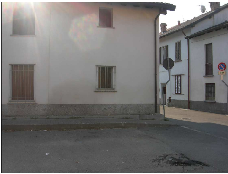
Posizione: Via d'Azeglio Tipologia: Impianti Resi Conformi
